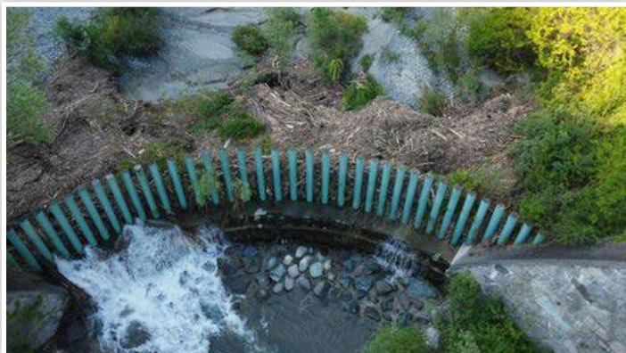
Barriere protettive sature di legname trasportato dall'alluvione della primavera 2025 (Condove, Torrente Gravio)
